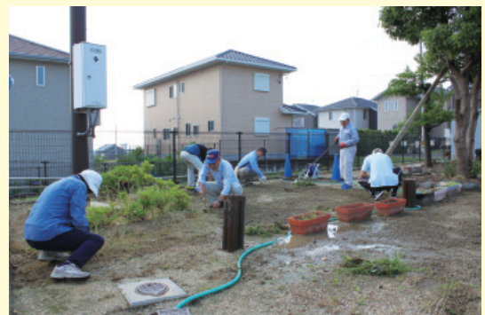
▲ 祠峯公園での作業風景
