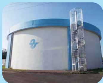
武豊第2配水池
