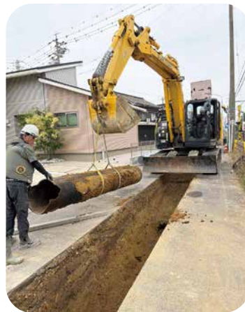
古い管の撤去作業
