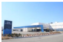
屋内温水プール (CCNCプールたけとよ)
