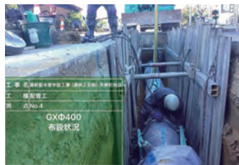
耐震管新設工事
