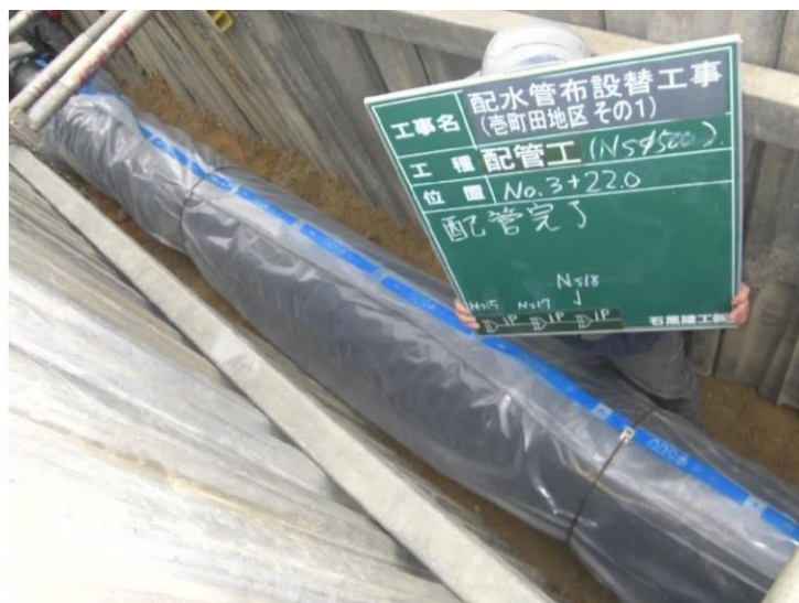
重要給水施設管路耐震化工事の実施状況
