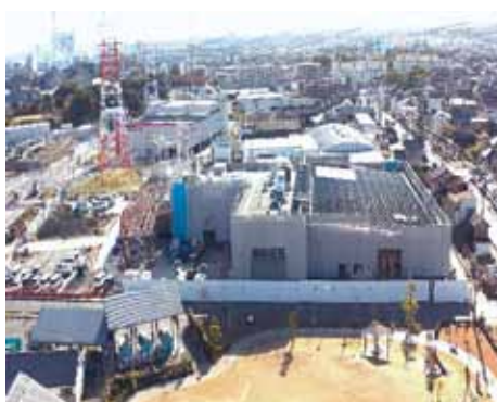
▲上空から見た 12月2日建設中の温水プール
