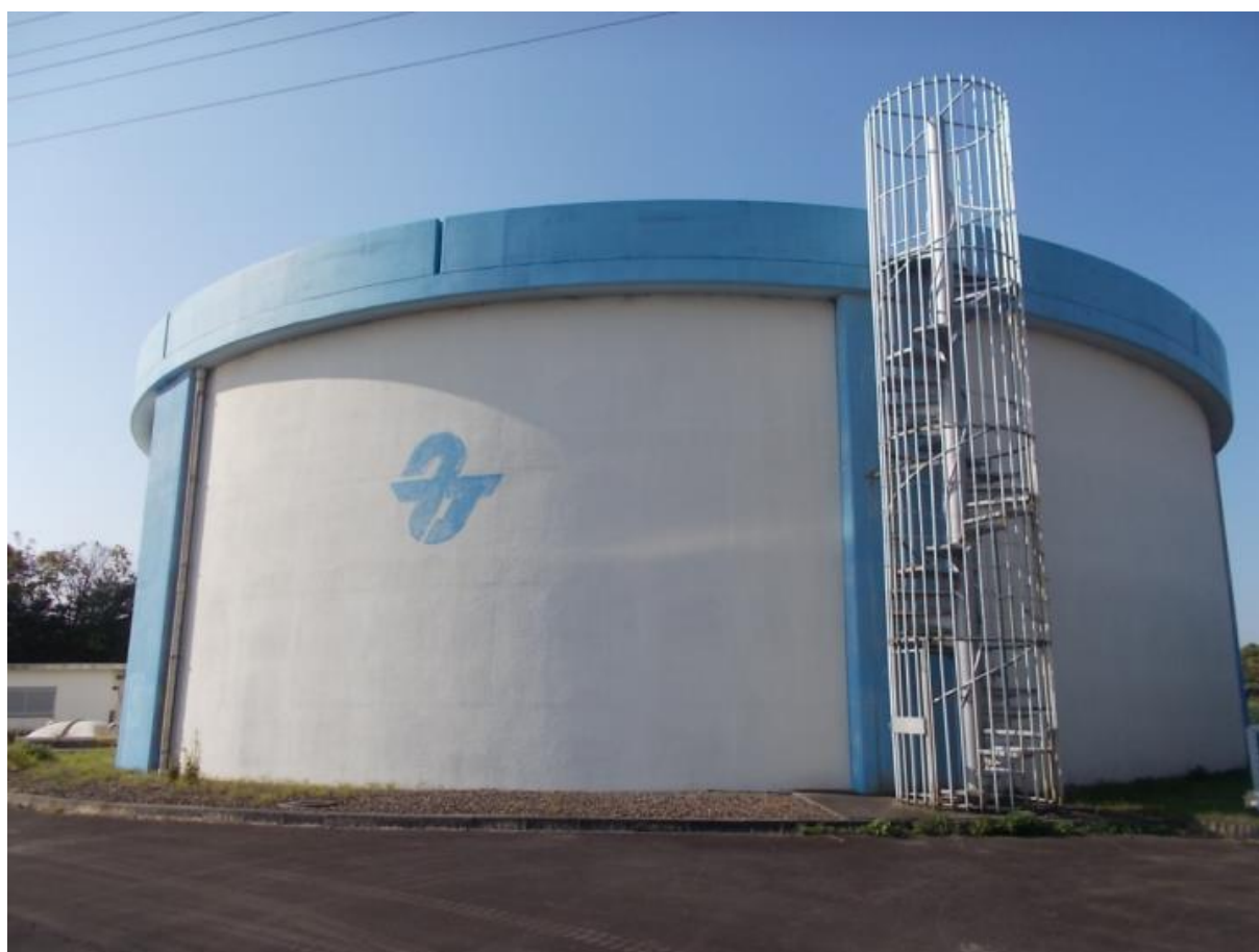
武豊第2配水池
