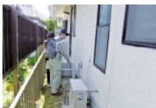
■ 建物の被害調査を行う小泉さん
