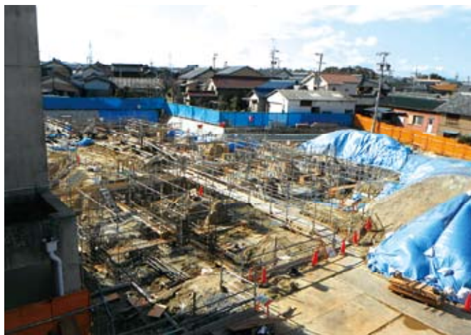
■ 工事中の富貴小学校体育館
