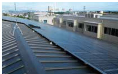
■富貴小学校の太陽光発電
