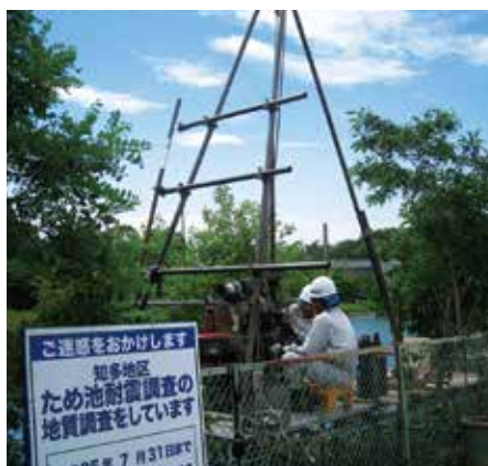
耐震調査をしている六貫山新池
