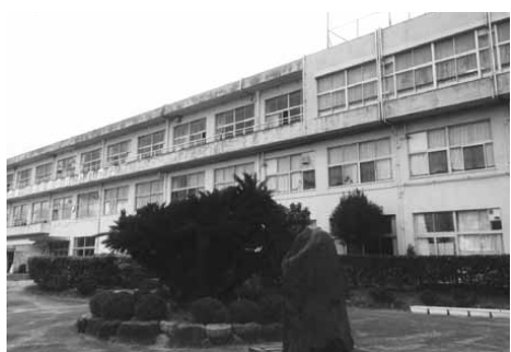
▲築30年以上経過し、劣化が進んでいる富貴小学校
