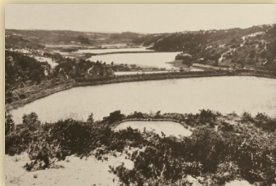
昔 昭和4年まで 別曾池 当時は3つの池(工事前)
