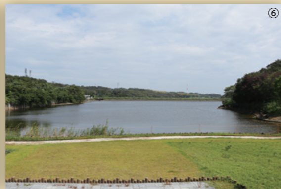
今 令和元年 別曾池(工事後)
