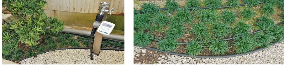
コントローラ と 吐水孔付きポリチューブ
