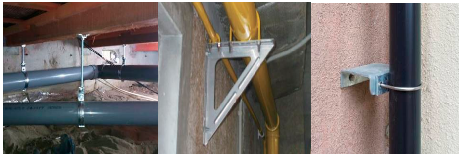
吊り・横主管・立管の施工写真〔例〕
