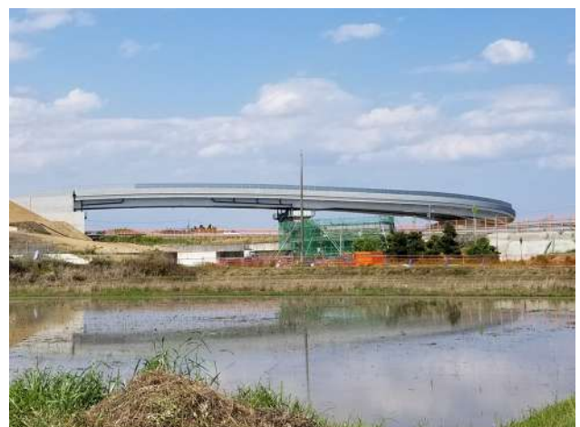
整備が進められている武豊北IC(仮称)
