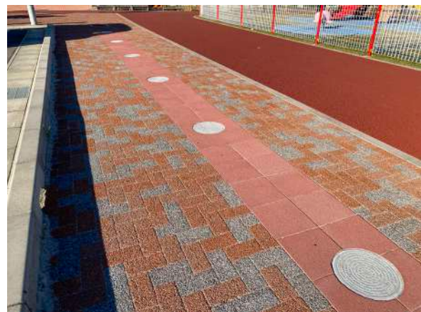
マンホールトイレ(武豊中央公園(北側)設置)
