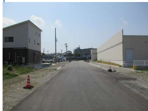
名鉄知多武豊駅東側の交通広場に接続する 区画道路の整備が進められている
