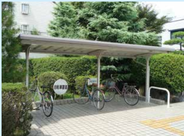
■屋根が設置された役場北駐輪場
