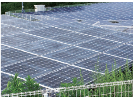
▲ 町内で見られる太陽光発電設備
