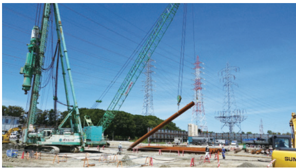
▲「中部電力武豊火力発電所 5号機の建設工事現場」
