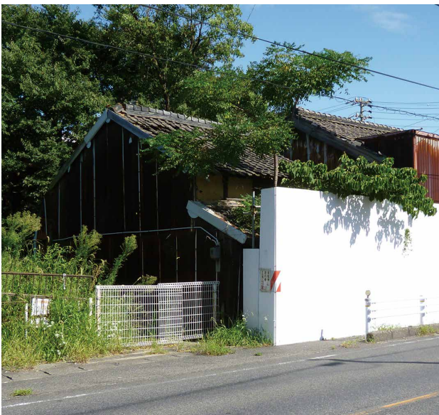
▲ 危険な空き家
