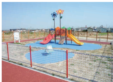
▲工事が進む武豊中央公園
