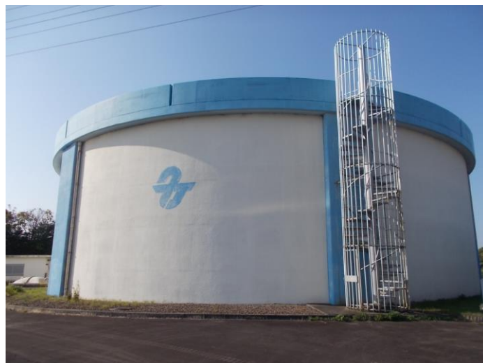
武豊第2配水池
