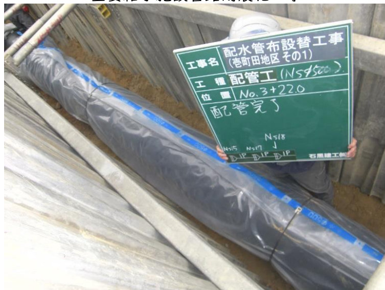
重要給水施設管路耐震化工事
