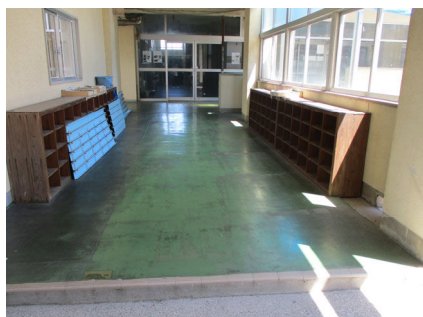
【衣浦小学校】渡り廊下
