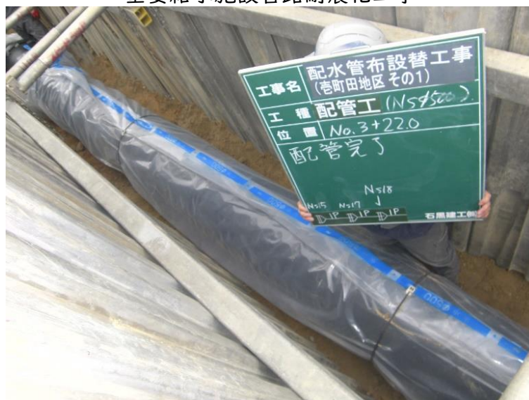
重要給水施設管路耐震化工事
