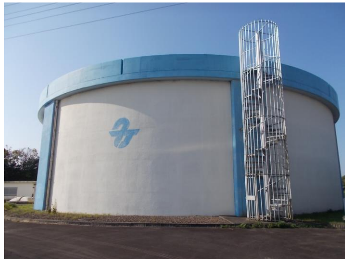
武豊第2配水池
