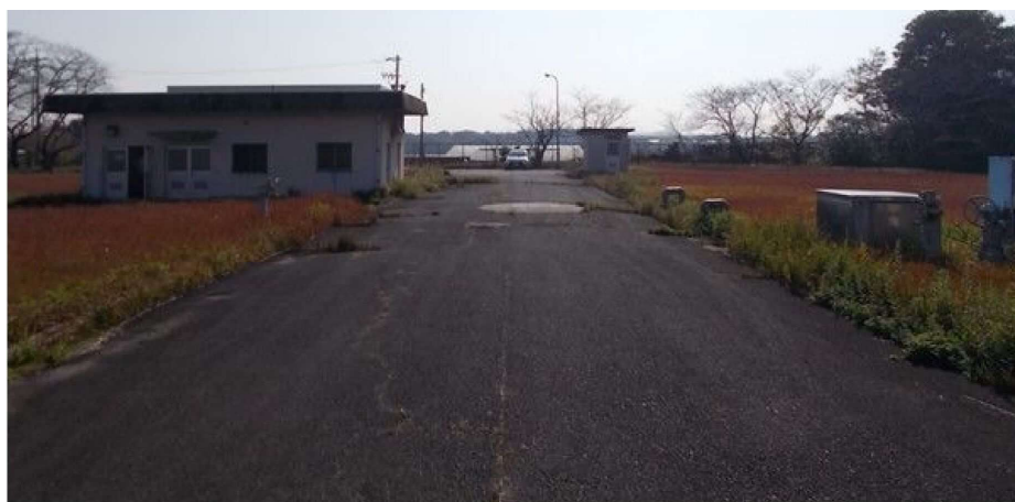
武豊第1配水場 配水池上部の状況
