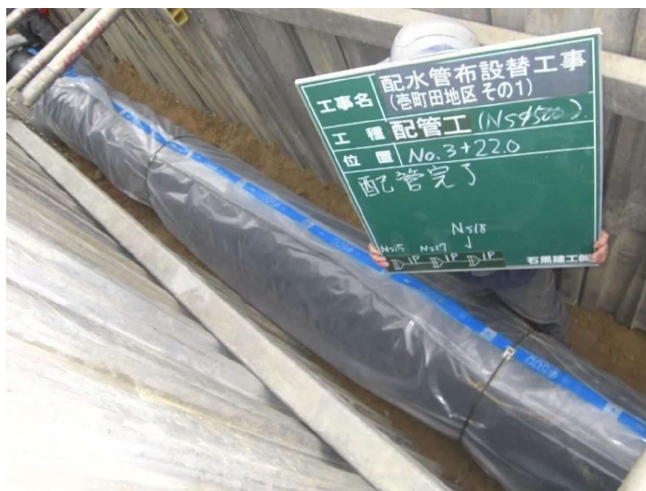
重要給水施設管路耐震化工事の実施状況
