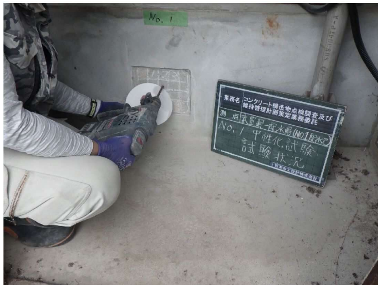
武豊第1配水場 点検調査の実施状況
