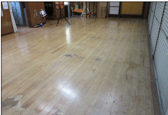
図 3-11 射場[床](はげれ・変形)
