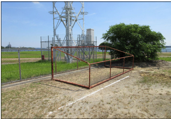
図 3-15 サッカーゴール(錆)
