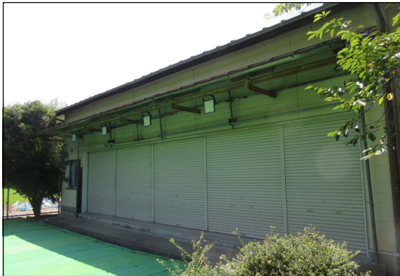
図 3-9 射場[軒骨組み](足場材で補強)
