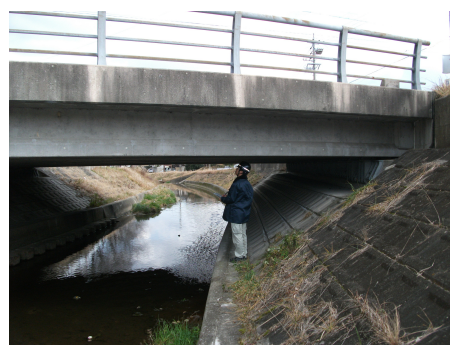
写真-3.4 職員による点検状況②
