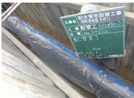
水道基幹管路耐震化工事
