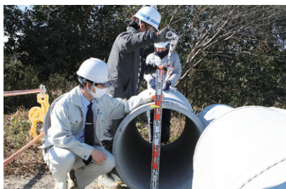
直接現場へ行き、工事の立ち会いを行う。
