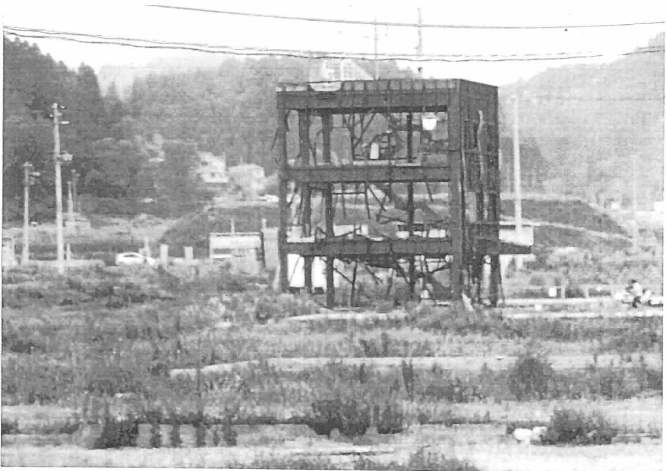
17 車窓からみえた南三陸 町の防災センター
