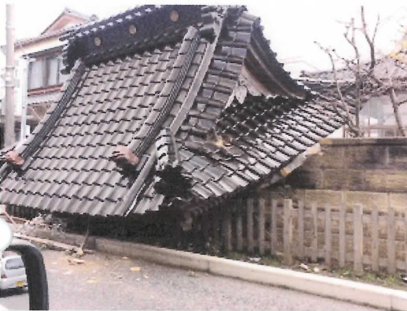
地震で倒壊した寺の鐘文き堂＝石川県輪島市河井町で2007年3月26日午後3時ごろ、川口弘明さん提供
