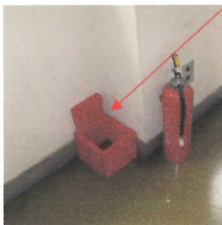
緑丘小校内の消火器は全てボックスで壁等に固定
