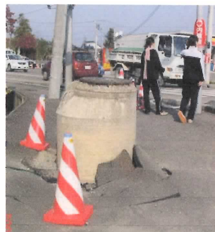
液状化で地盤沈下しマンホールが突き出た道路
