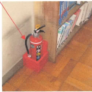
緑丘小校内の消火器は全てボックスで壁等に固定
