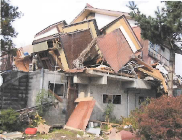
石川県輪島市 屋根が重く崩れた山門
