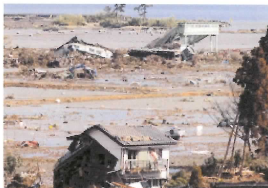
津波に押し流されて壊れた列車(左奥)と、からびて残った駅舎の一部＝12日午前10時0分、福島県新地町の常磐線新地駅、朝山東二撮影
