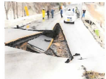
内陸でも盛土の道路が破壊され陥没した。
