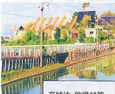
高城池 破堤対策
