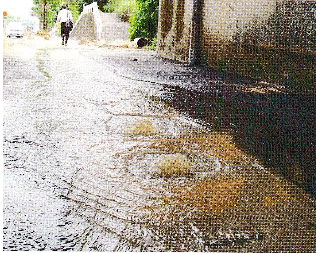
側溝から噴き出す水
