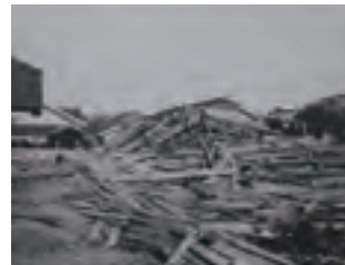
②倒壊した武豊小学校校舎
