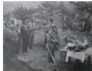
③配水池起工式
