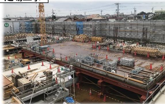
プールエリアでは鉄骨工事に向けて作業用の構台（足場）の設置工事を行いました。
