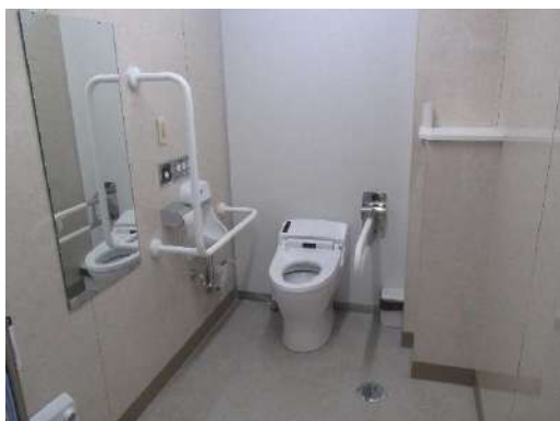
▲衣浦小学校多目的トイレ新設工事
