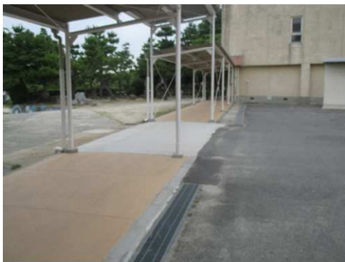
▲武豊小学校渡り廊下
