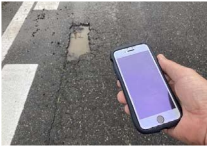
▲問題カ所を撮影・送信⇒修繕
