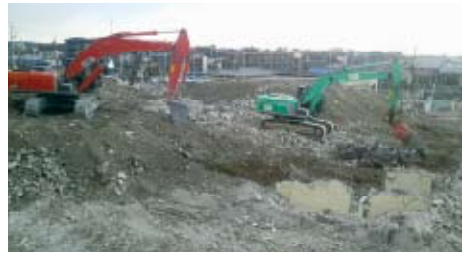
町外業者とJVを組み、取り壊される武豊中学校
