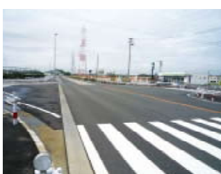
■開通した臨港道路
