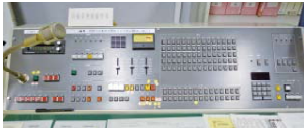
■武豊町防災センター
