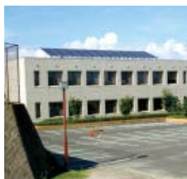
■太陽光発電設備がある保健センター
