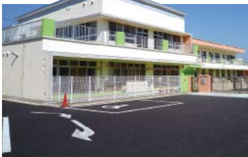
●六貫山保育園耐震改築事業
